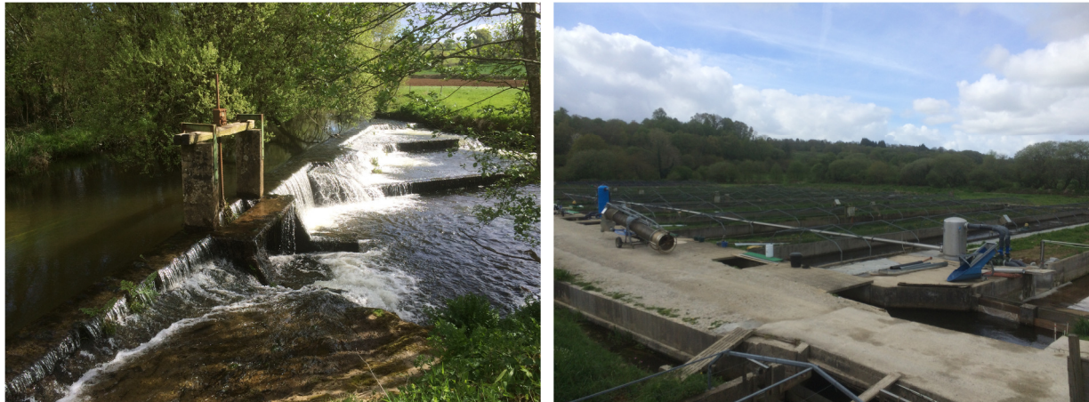
Figure 2-4 : Seuil d'alimentation de la pisciculture sur l'Odet – Vue générale des bassins d'élevage
