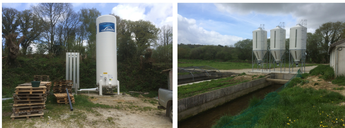
Figure 2-8 : Cuve de stockage (10 000L) de l'oxygène liquide – Silos de stockage de l'aliment (3 x15T)
